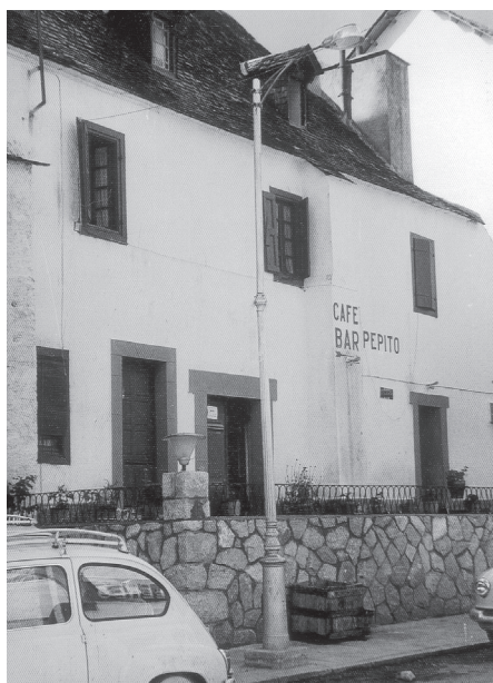
Fachada del Café Bar Pepito en el que trabajábamos mi madre y yo antes de la construcción del Urogallo.
