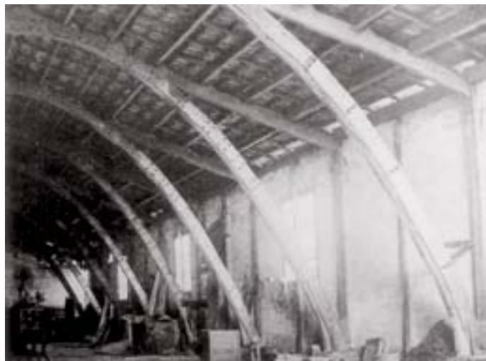
ДУБИЛЬНЫЙ ЦЕХ Неф Рабочего Кооператива Матаро по замыслу Гауди образован из двенадцати деревянных контактных арок. Фото дня.
