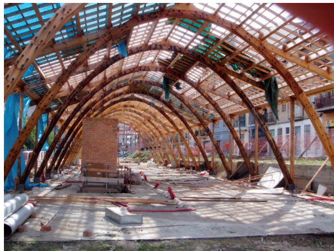
ESTRUCTURA DE LA NAVE
